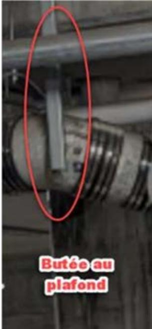
**10.15 Immobilisation flottante : ancrage entre deux pièces ou plus : plus difficile à réaliser**
